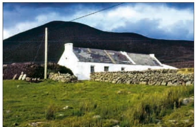
Das irische Bauernhaus dokumentiert den Mangel an Holz. Mauerwerk und Dachdeckung aus anstehendem Steinmaterial.
